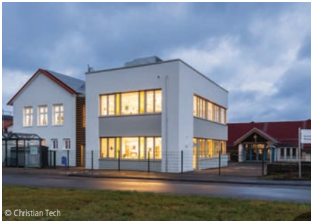
4100-0232 Schulmensa, Betreuungsräume Erweiterung
