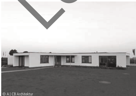
1300-0332 Bürogebäude (10 AP), Doppelgarage
