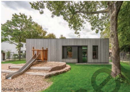
4400-0429 Kindertagesstätte (40 Kinder) Holz-Raumzellen Hochbauamt Heidelberg und AAg Architekten GmbH Heidelberg
