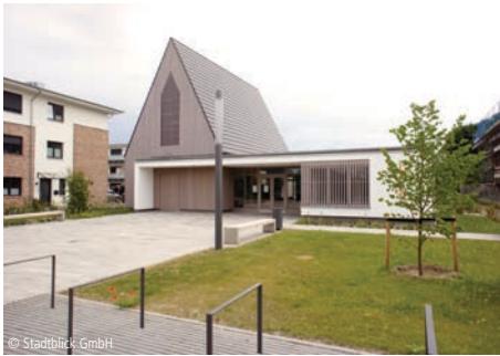
6400-0114 Kirchliches Gemeindezentrum Holzrahmenbau Stadtblick GmbH Hamburg
