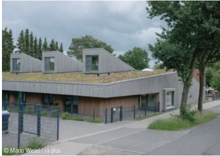
4400-0407 Kindertagesstätte (90 Kinder) Holzrahmenbau ra plus | mevißen hillmann harder hille architekten- partnerschaft mbB, Hannover
