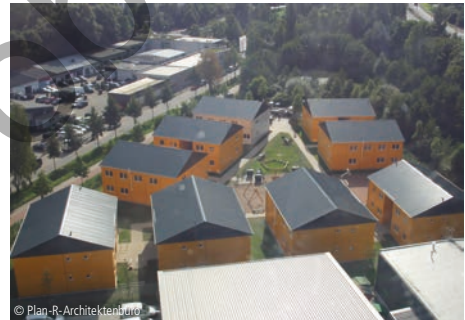
6100-1282 Modulhäuser (34 WE) Stahl-Raumzellen Plan-R-Architektenbüro Hamburg
