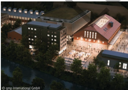
9100-0226 Konzertsaal (1.956 Sitzplätze) Stahlbau gmp International GmbH Berlin
