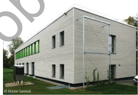
2200-0068 Seminar-/Verwaltungsgebäude Holz-Raumzellen meuer - planen beraten Architekten GmbH München
