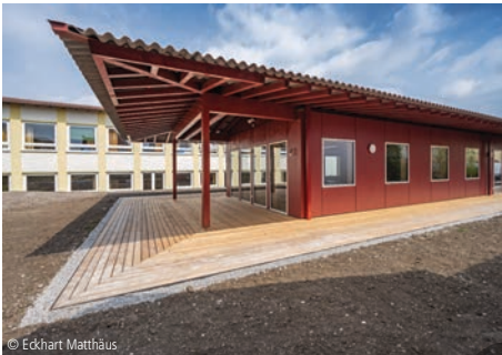
4300-0026 Förderschule, Erweiterungsbau Holzrahmenbau
