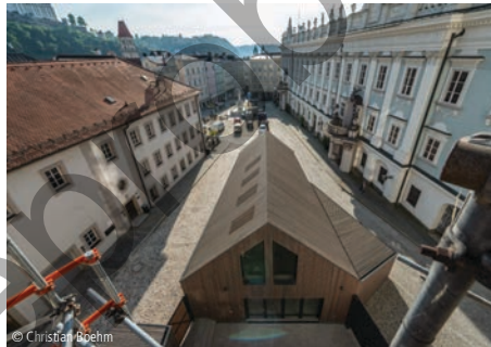
7300-0114 Werkstattgebäude (10 AP) Massivholzbau Arc Architekten Partnerschaft mbB Bad Birnbach
