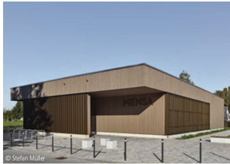
6500-0055 Schulmensa (160 Sitzplätze) Holzrahmenbau Renner Architekten GmbH Berlin
