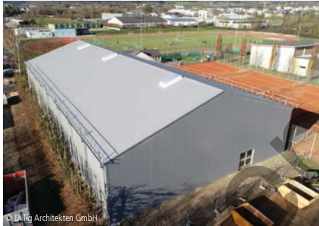
5100-0134 Stahlleichtbauhalle Stahlbau Dilling Architekten GmbH Simmern
