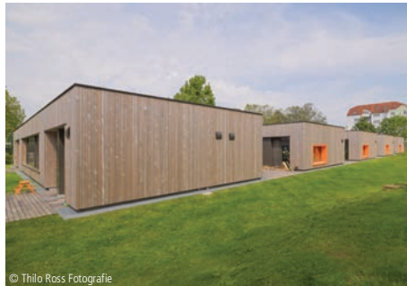
4400-0389 Kindertagesstätte (100 Kinder) Holz-Raumzellen Hochbauamt Heidelberg und AAg Architekten GmbH Heidelberg
