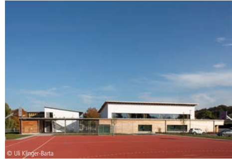
5100-0131 Sporthalle (Einfeldhalle) Holzrahmenbau Wagner Architekten Dingolfing
