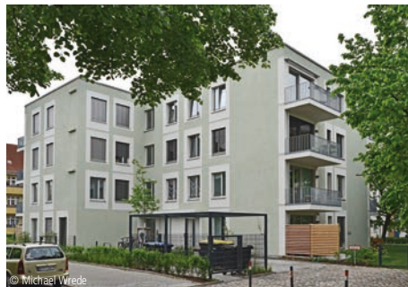
© Michael Wiede 6100-1454 Mehrfamilienhaus (17 WE) - Effizienzhaus ~63% Seite 162
