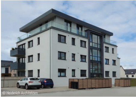
6100-1608 Mehrfamilienhaus (11 WE), TG (9 STP)
