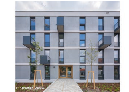
© Sebastian Johnke 6100-1480 Mehrfamilienhaus (22 WE) - Effizienzhaus ~67% Seite 384 CKRS ARCHITEKTEN Berlin
