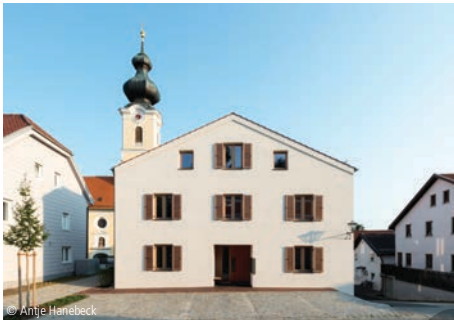
6100-1589 Mehrfamilienhaus (7 WE), TG (5 STP)
