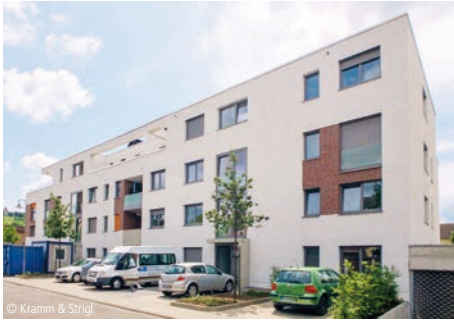
6100-1479 Mehrfamilienhaus (25 WE), TG (35 STP)
