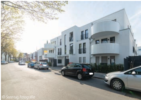
6100-1585 Mehrfamilienhaus (15 WE), TG (17 STP)
