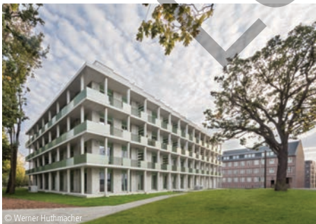
6100-1494 Mehrfamilienhaus (53 WE), TG (13 STP)
