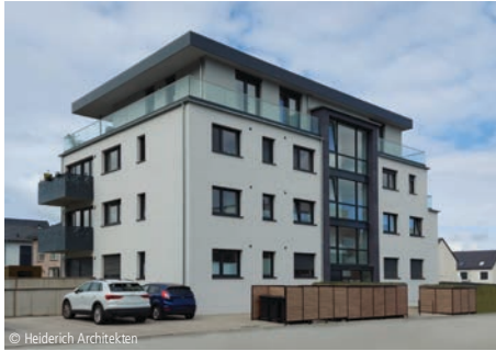
6100-1608 Mehrfamilienhaus (11 WE), TG (9 STP)
