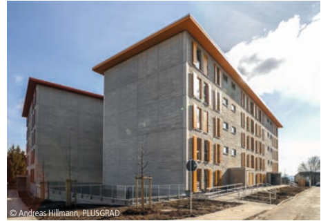
6100-1413 Mehrfamilienhaus (30 WE), TG (30 STP)
