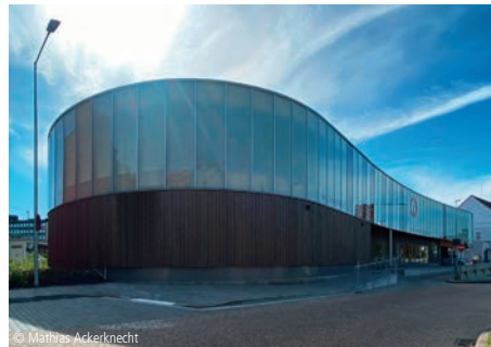
7800-0030 Fahrradparkhaus (224 STP) Sonstige Gebäude
