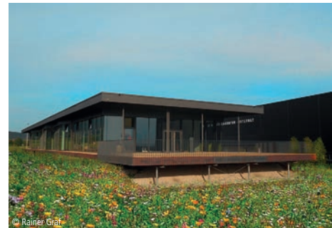
© Rainer Graf 1300-0259 Bürogebäude (30 AP) - Effizienzhaus ~53% Büro- und Verwaltungsgebäude RAINER GRAF architekten GmbH Offerdingen
