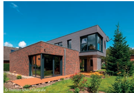
© Thorsten Scherz Fotografie 6100-1546 Einfamilienhaus, Carport Ein- und Zweifamilienhäuser, nicht unterkellert Henschke Schulze Reimers Architekten Lüneburg
