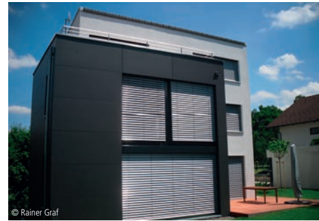
© Rainer Graf 6100-0796 Einfamilienhaus - Passivhaus* Ein- und Zweifamilienhäuser, Passivhausstandard Architekt Rainer Graf Architektur + Energiekonzepte Offerdingen
