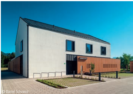
6200-0115 Hospiz (10 Betten) Sonstige Gebäude Sweco GmbH, München und HSP Projektmanagement, Beratung GmbH, Töging
