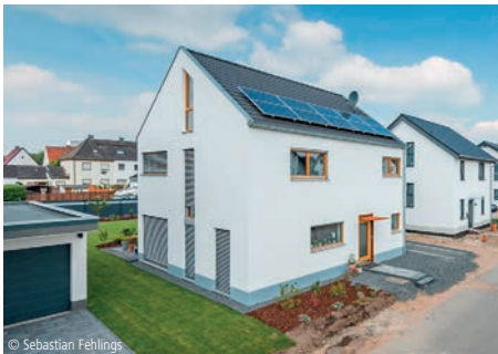
© Sebastian Fehlings 6100-1360 Einfamilienhaus, Garage - Passivhaus Ein- und Zweifamilienhäuser, Passivhausstandard bau grün ! energieeffiziente Gebäude Mönchengladbach
