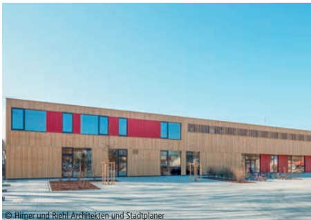
© Hirner und Riehl Architekten und Stadtplaner 4400-0240 Kindertagesstätte (6 Gruppen, 149 Kinder)* Kindergärten, nicht unterkellert ☞ Hirner und Riehl Architekten und Stadtplaner BDA München
