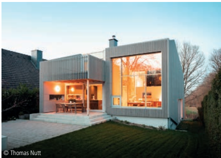
© Thomas Nutt 6100-1535 Einfamilienhaus Ein- und Zweifamilienhäuser, unterkellert Laura Hirsch Architektin Hamburg
