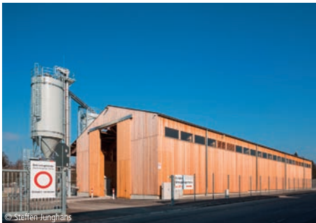
7700-0090 Streugutlagerhalle Sonstige Gebäude
