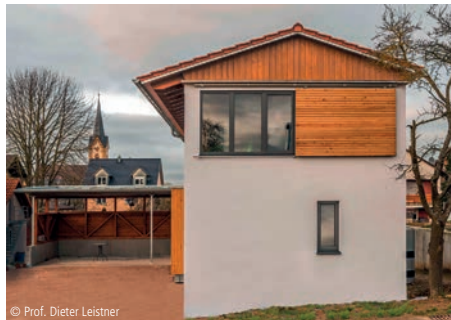
© Prof. Dieter Leistner 6100-1527 Einfamilienhaus Ein- und Zweifamilienhäuser, unterkellert claus arnold architekt bda Würzburg
