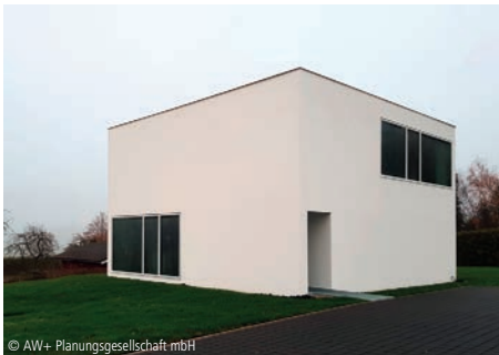
© AW+ Planungsgesellschaft mbH 1300-0254 Bürogebäude (8 AP) - Effizienzhaus ~73% Büro- und Verwaltungsgebäude AW+ Planungsgesellschaft mbH Eiterfeld
