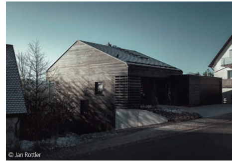
© Jan Rottler 6100-1564 Einfamilienhaus, Garage Ein- und Zweifamilienhäuser, unterkellert Partner und Partner Architekten Berlin
