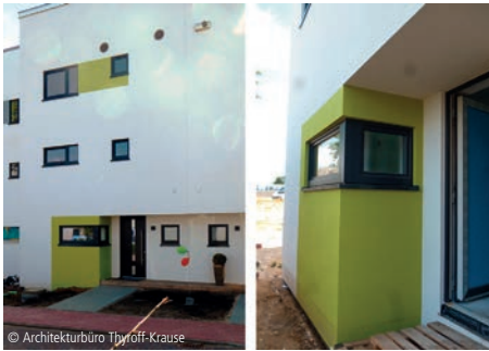
6100-1156 Reihemittelhaus - Passivhaus Ein- und Zweifamilienhäuser, Passivhausstandard Architekturbüro Thyroff-Krause Kaltenkirchen
