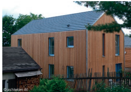
6100-1018 Einfamilienhaus - Passivhaus Ein- und Zweifamilienhäuser, Passivhausstandard architekten dd Dipl.-Ing. Dietmar Eichelmann Dresden
