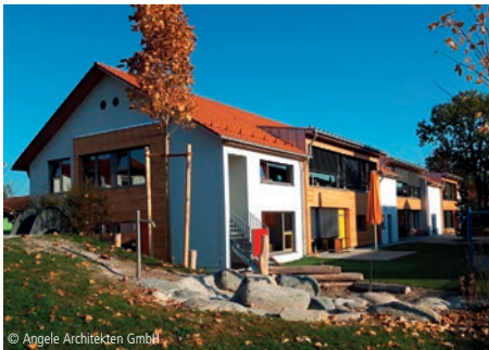
4400-0339 Kindertagesstätte (99 Ki) - Effizienzhaus ~26%* Kindergärten, nicht unterkellert
