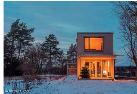
© Dieter Leistner 6100-1568 Einfamilienhaus, Carport Ein- und Zweifamilienhäuser, unterkellert claus arnold architekt bda Würzburg
