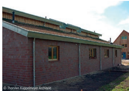
© Thorsten Kappelmeyer Architekt 6100-0491 Doppelhaushälfte - 3-Liter-Haus* Ein- und Zweifamilienhäuser, nicht unterkellert Thorsten Kappelmeyer Dipl.-Ing. Architekt Hannover
