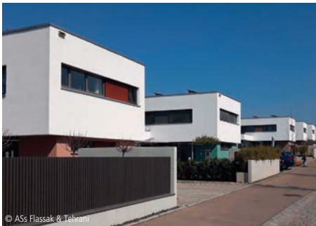
© ASs Flassak & Tehrani 6100-1541 Einfamilienhäuser (6 WE) - Effizienzhaus ~31% Sonstige Gebäude ASs Flassak & Tehrani Freie Architekten und Stadtplaner, Stuttgart
