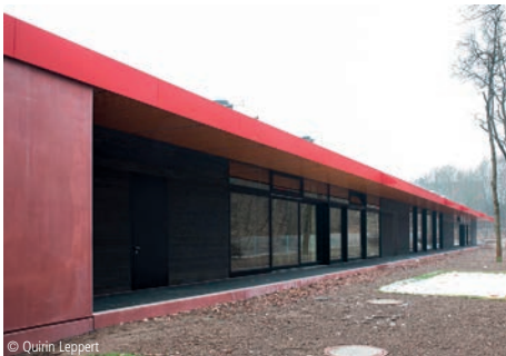
© Quinn Leppert 4400-0256 Kinderkrippe (4 Gr, 48 Ki) - Effizienzhaus ~76%* Kindergärten, nicht unterkellert Schindhelm Moser Architekten München
