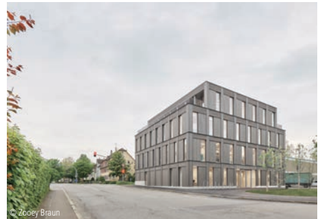
1300-0335 Verwaltungsgebäude (40 AP) Seite 114
