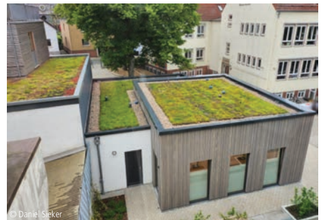
1300-0342 Verwaltungsgebäude (9 AP) Seite 152
