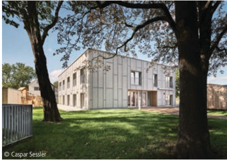
6100-1685 Mehrfamilienhäuser (9 WE), Kita
