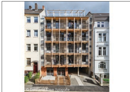
6100-1772 Mehrfamilienhaus (9 WE, 3 STP)
