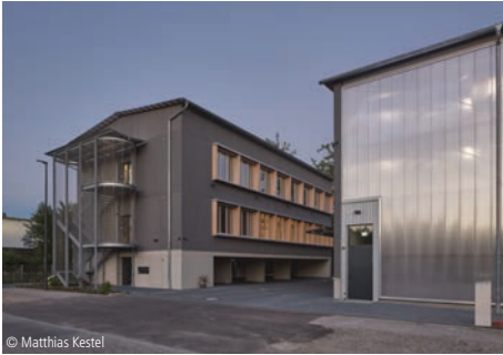
1300-0344 Bürogebäude (50 AP), Garage
