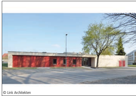
7600-0108 Feuerwehr Übungsanlage Seite 868
