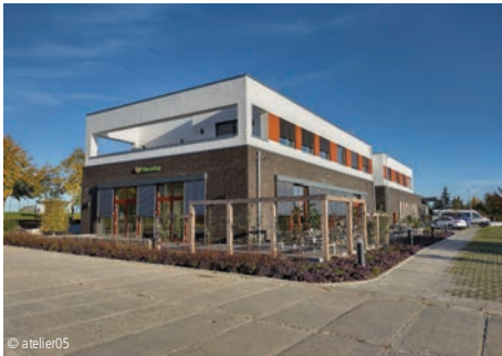
6500-0063 Verwaltungsgebäude (20 AP) Seite 782
