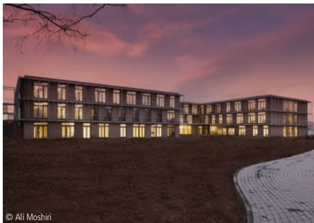
1300-0316 Verwaltungsgebäude (191 AP) Seite 92
