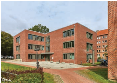
1300-0262 Verwaltungsgebäude (48 AP) Seite 66
