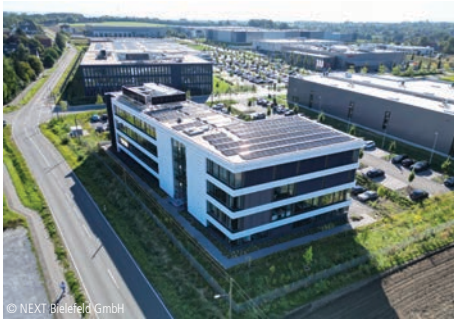
1300-0325 Verwaltungsgebäude (90 AP) Seite 118
