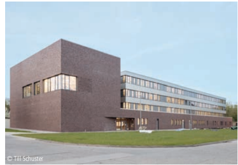
1300-0313 Verwaltungsgebäude (134 AP) Seite 74
