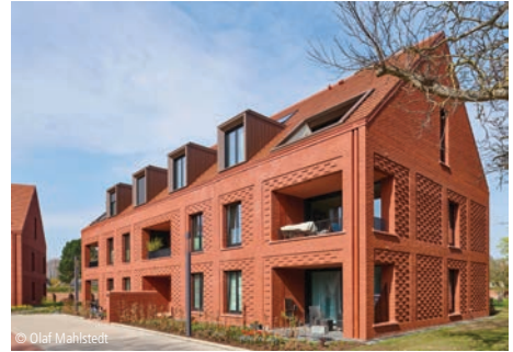
© Olaf Mahstedt 6100-1675 Mehrfamilienhäuser (2 Gebäude, 15 WE) Seite 698
