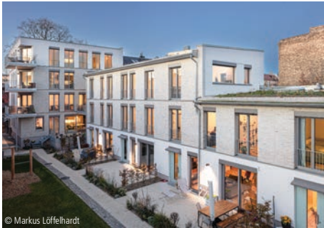
© Markus Löffelhardt 6100-1605 Mehrfamilienhaus (11 WE) Seite 444 pfeifer architekten und Patzschke Schwebel Planungsgesellschaft mbH und wbs3 architekten, Berlin
