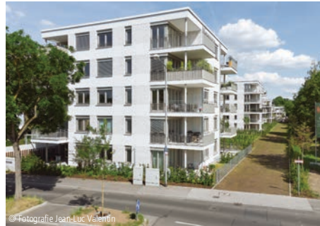
6100-1622 Mehrfamilienhäuser (5 Gebäude, 66 WE), TG Seite 522
