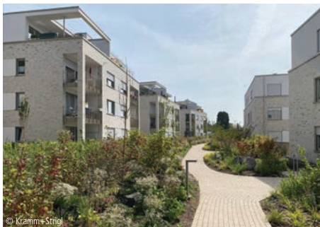
© Kramm+Strigl 6100-1656 Mehrfamilienhäuser (82 WE), TG (70 STP) Seite 636
