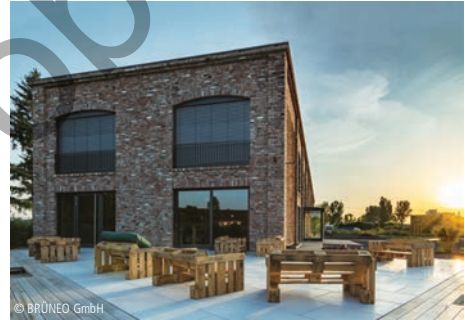
© BRÜNEO GmbH 1300-0304 Bürogebäude (84 AP)
