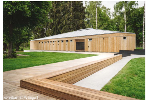
5300-0019 Flussbad, Eingangsgebäude, Brücke
