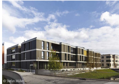
6100-1567 Mehrfamilienhaus (21 WE), TG (20 STP)
