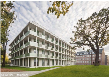
6100-1494 Mehrfamilienhaus (53 WE), TG (13 STP)
