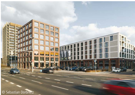
6100-1548 Mehrfamilienhaus (62 WE), Bürogebäude, TG (124 STP)
