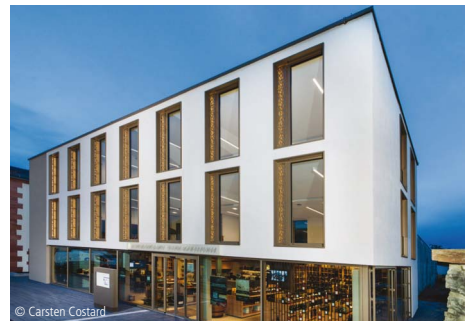
1300-0288 Bürogebäude (34 AP), Vinothek
