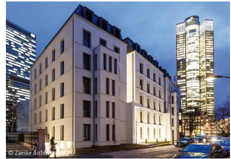
6100-1534 Mehrfamilienhaus (33 WE), TG (34 STP)
