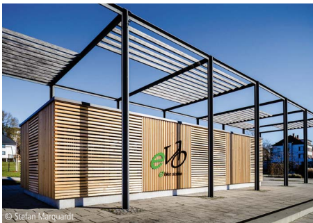
7800-0027 Fahrradpavillon mit E-Bike-Ladestation (19 STP)
