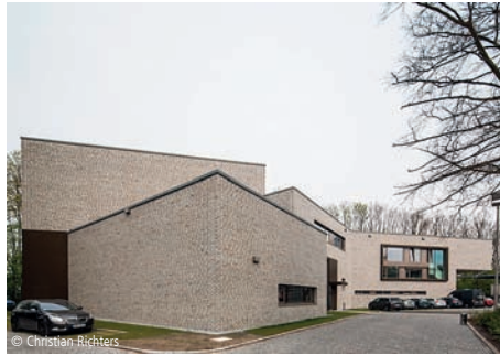
2200-0051 Lehrsaaalgebäude, Institut der Feuerwehr Seite 92
