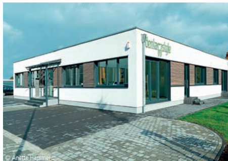
© Anette Hammer 7100-0054 Laborgebäude (23 AP)
