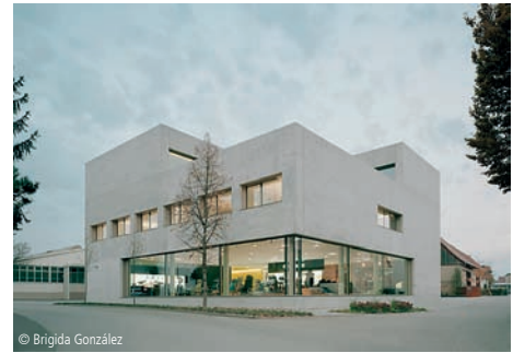
1300-0233 Büro- und Ausstellungsgebäude (32 AP) Seite 56
