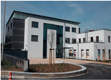
© Ellen Bornkessel 3100-0029 Praxis-, Labor- und Bürogebäude
