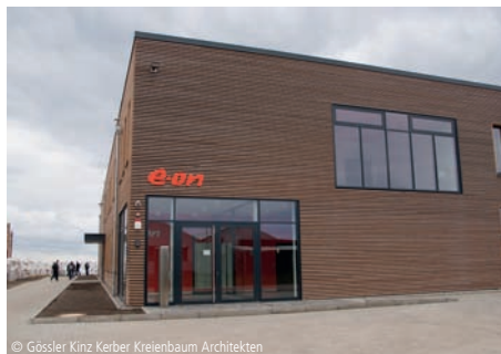
7300-0088 Betriebsgebäude (22 AP) - Helgoland Seite 664
