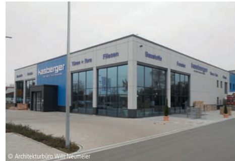
7200-0088 Baufachmarkt, Ausstellungsgebäude Seite 640
