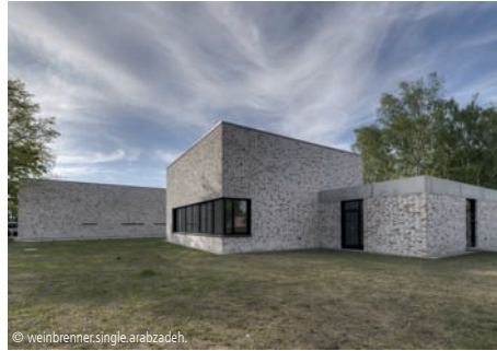
5100-0104 Sporthalle (Dreifeldhalle), Therapiebereich
