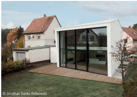
© Jonathan Danko Kielkowski 6100-1301 Einfamilienhaus, Garage - Effizienzhaus 85 Seite 542
