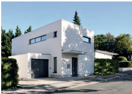
© Chiara Nardoni 6100-1265 Einfamilienhaus, Garage
