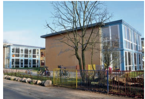
4400-0134 Kindertagesstätte (261 Kinder) Seite 210 Modernisierung ☞ Ingenieurbüro Matthias Kühn Anklam
