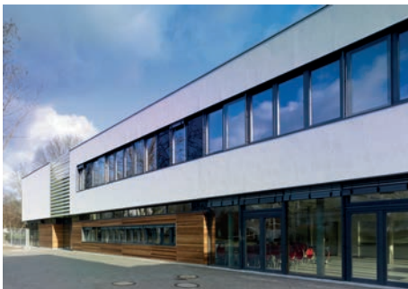
4100-0140 Grundschule (4 Kl.) - Passivhaus Seite 138
