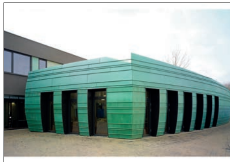
4100-0145 Grundschule (4 Kl.) - Passivhaus Seite 148
