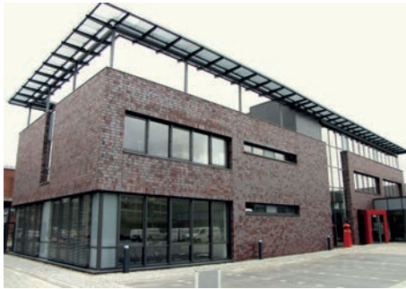
7100-0042 Lager, Werkstatt- und Bürogebäude Seite 470
