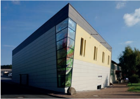
7700-0065 Material- und Weinlager Seite 522
