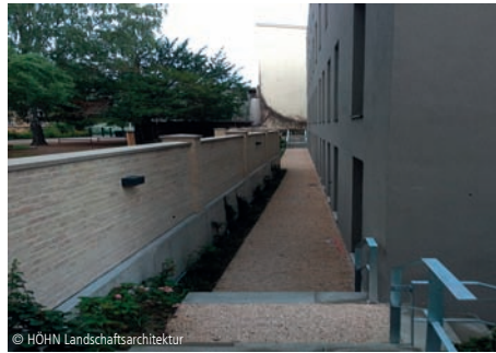
© HÖHN Landschaftsarchitektur 3200-0030 Grundstücksmauer Krankenhaus Seite 110
