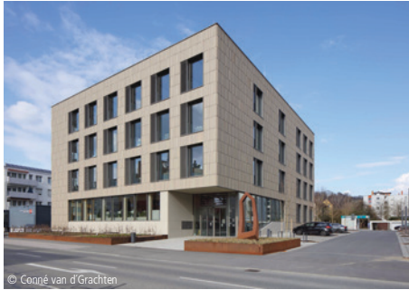
1300-0295 Außenanlage Landratsamt Seite 98
