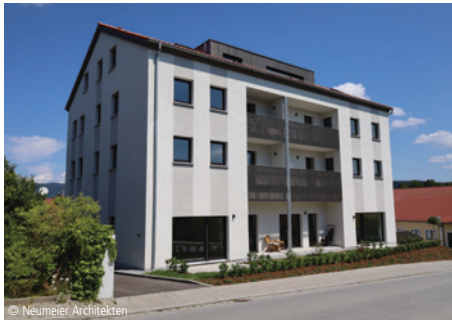
© Neumeier Architekten 6100-1637 Außenanlage Mehrfamilienhaus (11 STP) Seite 346
