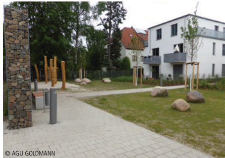
6100-1665 Außenanlage Mehrfamilienhäuser Seite 410
