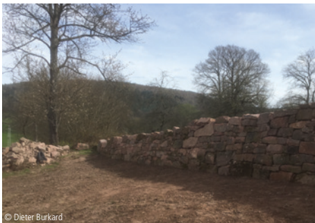
© Dieter Burkard 9100-0221 Trockenmauer Seite 634 Instandsetzung
