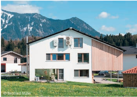
© Bernhard Müller 6100-1325 Einfamilienhaus - Effizienzhaus 40
