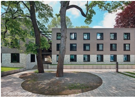
© Sigurd Steingrube 6200-0083 Studentenwohnheim, Verwaltung - Effizienzhaus ~26% Seite 668 ACMS Architekten GmbH Wuppertal
