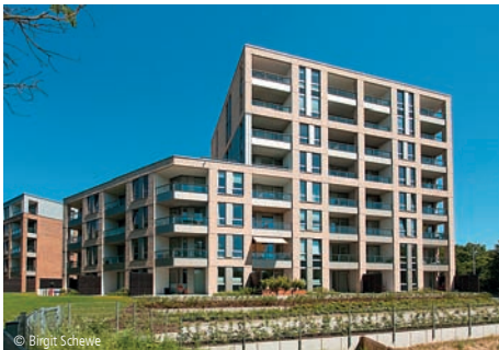
6100-1362 Mehrfamilienhäuser (66 WE) - Effizienzhaus 70 Seite 548
