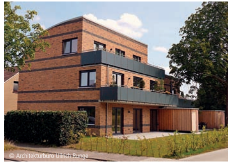
© Architekturbüro Ullrich Runge 6100-1398 Mehrfamilienhaus (5 WE) - Effizienzhaus 70 Seite 626
