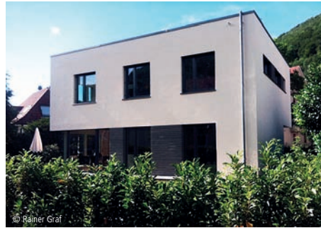
6100-1339 Einfamilienhaus, Garage - Effizienzhaus 40 Seite 464 🏠 Architekt Rainer Graf Architektur + Energiekonzepte Ofterdingen
