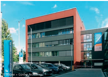
© Wagner + Günther Architekten 1300-0239 Technologiezentrum - Effizienzhaus ~62% Seite 100
