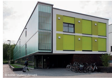
© Kölner Studierendenwerk 6200-0086 Studentenwohnheim (62 Betten), TG (22 STP) - Passivhaus Seite 674 HU MA N hussmann und macht architektur | design GbR, Köln
