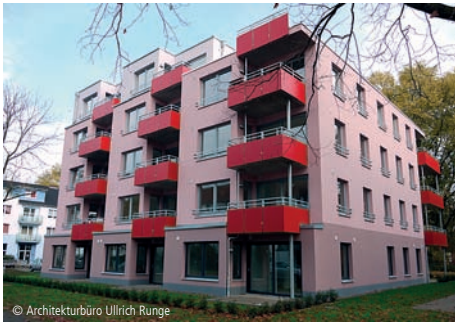
© Architekturbüro Ullrich Runge 6100-1397 Mehrfamilienhaus (23 WE) - Effizienzhaus ~67% Seite 620
