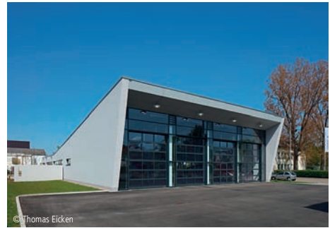
© Thomas Eicken 7600-0076 Feuerwehrgerätehaus, Übungsturm - Passivhaus Seite 764
