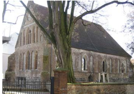
9100-0088 Kapelle Seite 644 Instandsetzung
