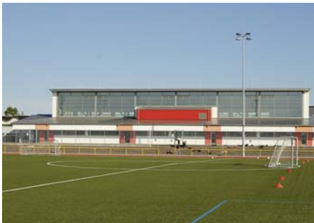
5100-0093 Sporthalle (Dreifeldhalle) Seite 264 Modernisierung 🏠 DILLIG-ARCHITEKTEN GmbH Simmern
