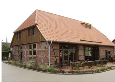
6500-0029 Backshop und Café Seite 386 Umbau Die Planschmiede 2KS GmbH & Co. KG Hankensbüttel
