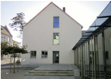
9100-0093 Gemeindehaus Modernisierung Architekturbüro Michael Dittmann Amberg
