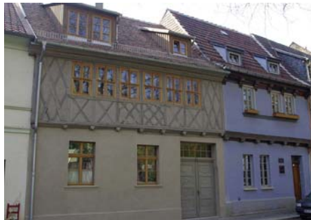
6100-0946 Einfamilienhaus, Einzeldenkmal Seite 492 Instandsetzung
