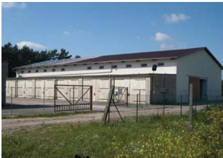
7300-0072 Lagerhalle, Werkstatt Seite 584 Instandsetzung
