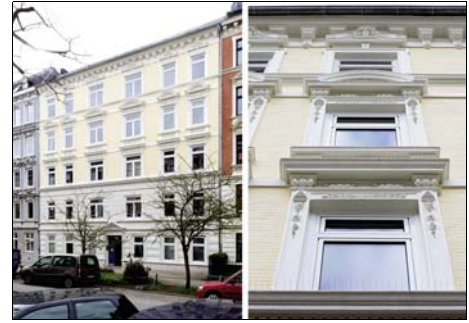
6100-1112 Mehrfamilienhaus, Denkmalschutz Seite 516 Instandsetzung
