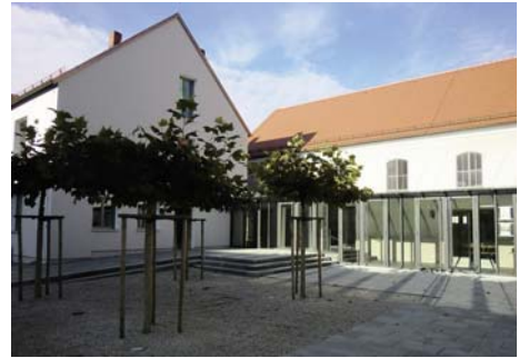
9100-0092 Evangelische Kirche, Gemeindesaal Umbau Architekturbüro Michael Dittmann Amberg
