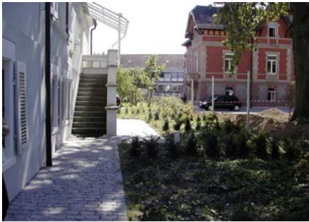
6100-1099 Mehrfamilienhaus, Grundmauersan. Seite 508 Instandsetzung
