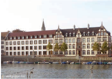
6200-0133 Pflegeheim (22 Betten) Seite 416 Umbau
