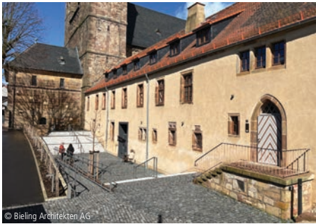
9100-0215 Stiftsgebäude, Gemeindesaal, Büros Seite 618 Umbau
