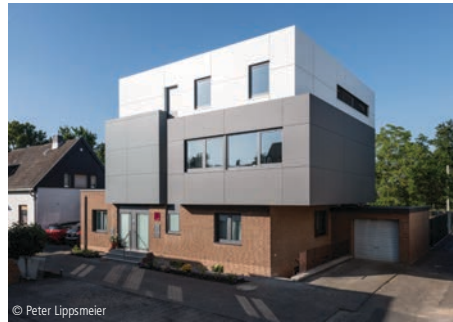
6100-1746 Einfamilienhaus Aufstockung Seite 316 Erweiterung Gütig Architektur Bornholm-Hersel
