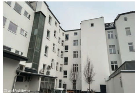
1300-0322 Wohn-/Geschäftshaus, Fassade Seite 174 Modernisierung werkArchitektur Yvonne Werk Berlin
