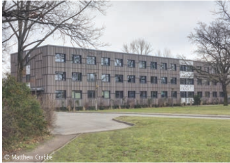
1300-0270 Verwaltungsgebäude (75 AP) Seite 100 Modernisierung ZRS Architekten GvA mbH Berlin
