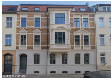
6100-1760 Mehrfamilienhaus (4 WE) Seite 522 Instandsetzung ding.fest dessau architektur & energieberatung Dessau-Roßlau
