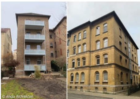
6100-1753 Mehrfamilienhaus (8 WE) Seite 504 Instandsetzung Ahola Architekten Braunschweig
