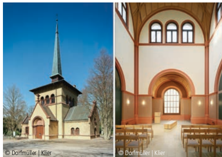
9700-0032 Friedhofskapelle Seite 708 Instandsetzung
