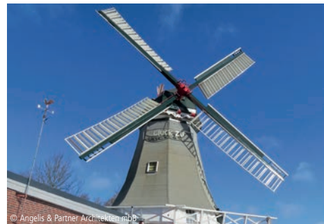
© Angelis & Partner Architekten mbB 9100-0130 Windmühle (Baudenkmal) Seite 628 Instandsetzung Angelis & Partner Architekten mbB Oldenburg
