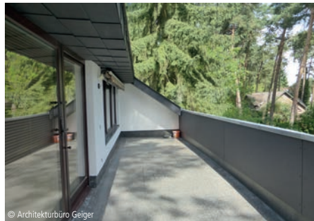
© Architekturbüro Geiger 6100-1150 Balkon (Mehrfamilienhaus) Seite 576 Instandsetzung Architekturbüro Geiger Berlin
