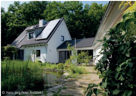
© Hans-Jörg Peter Architekt 6100-1138 Einfamilienhaus Seite 470 Modernisierung Hans-Jörg Peter Architekt Hamburg
