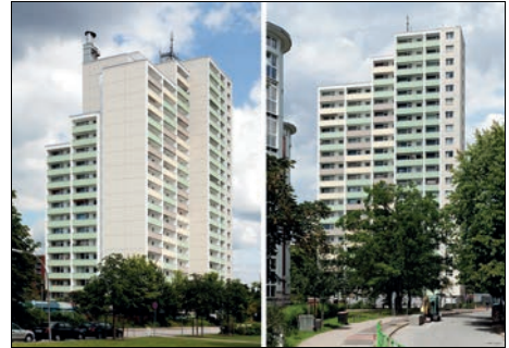
6100-1111 Wohnhochhaus (179 WE) Modernisierung Seite 446 Mannott + Mannott Dipl. Ingenieure, Architekten Hamburg
