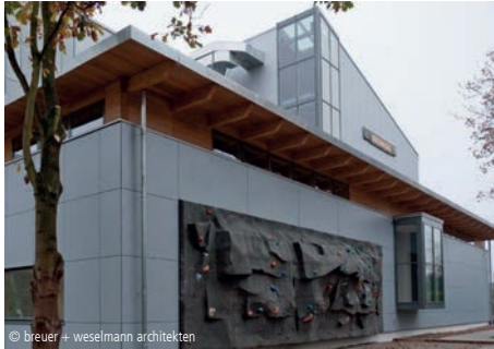
© breuer + weselmann architekten 5600-0010 Kletterhalle, Verwaltung Erweiterung Seite 328 breuer + weselmann architekten Hamburg
