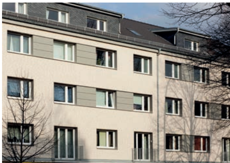
6100-1113 Wohn- und Geschäftshaus (21 WE) Instandsetzung Seite 564 Mannott + Mannott Dipl. Ingenieure, Architekten Hamburg
