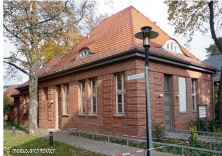
2200-0033 Institutsgebäude Seite 150 Modernisierung
