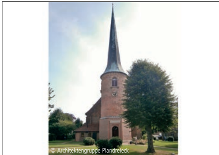
© Architektengruppe Plandreeck 9100-0114 Glockenturm Seite 618 Instandsetzung Architektengruppe Plandreeck Elmshorn
