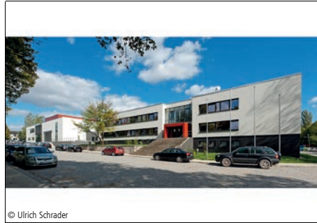
2200-0035 Verwaltungsgebäude Seite 166 Modernisierung
