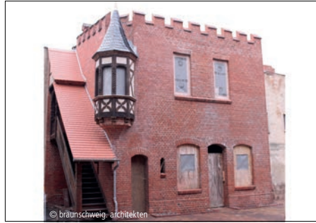
© braunschweig. architekten 9900-0004 Ateliergebäude Seite 634 Instandsetzung
