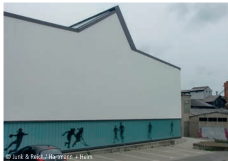
5100-0077 Schulsporthalle (Dreifeldhalle) Seite 340 Instandsetzung
