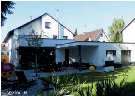
© ABSB Michalik 6100-1051 Mehrfamilienhaus, Büro, Garage Modernisierung Seite 432 ABSB Michalik Bad Elster
