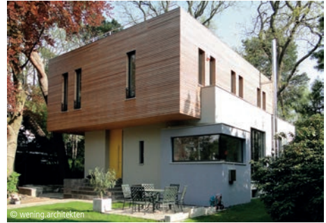
© wening.architekten 6100-1180 Einfamilienhaus Seite 396 Erweiterung wening.architekten Potsdam
