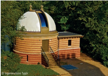
2200-0034 Institut Klimafolgenforschung Seite 136 Umbau
