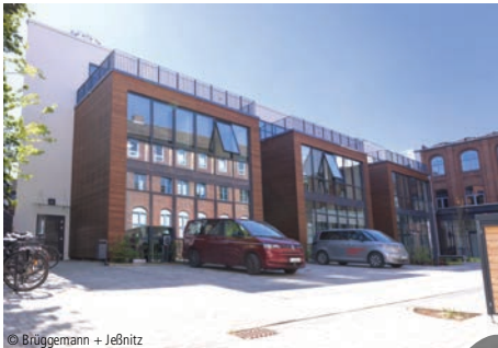
1300-0339 Bürogebäude (40 AP) Erweiterungen; Büro- und Verwaltungsgebäude Brüggemann + Jeßnitz Architekten Part GmbH Winsen (Aller)
