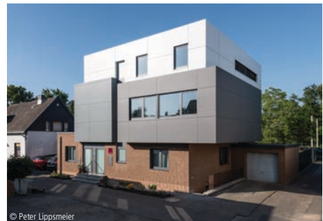
6100-1746 Einfamilienhaus, Aufstockung Erweiterungen; Wohngebäude: Aufstockung
