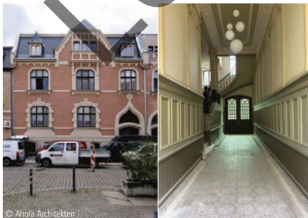
6100-1733 Mehrfamilienhaus (11 WE) Instandsetzungen; Wohngebäude
