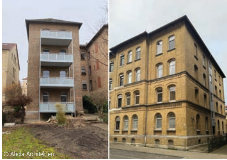
6100-1753 Mehrfamilienhaus (8 WE) Instandsetzungen; Wohngebäude Ahola Architekten Braunschweig
