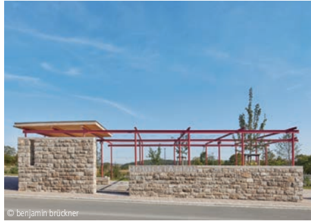
© benjamin brückner 7800-0047 Mobilstation (10 Fahrräder) Fahrradparkhäuser claus arnold architekt bda Würzburg
