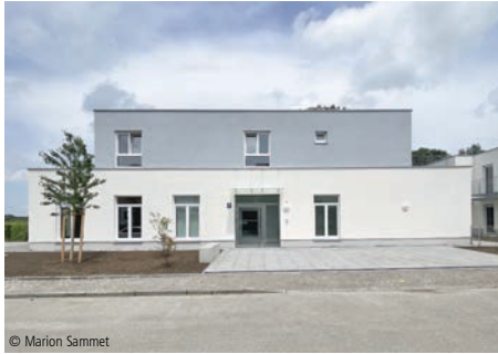
© Marion Sammet 6100-1747 Wohnanlage (15 WE), Gemeindesaal Wohnhäuser, mit mehr als 15% Mischnutzung meuer - planen beraten Architekten GmbH München
