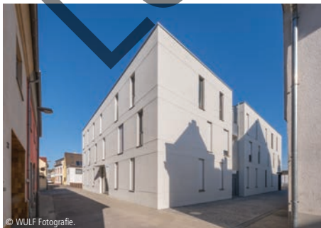
© WJLF Fotografie 6100-1805 Mehrfamilienhaus (9 WE) Mehrfamilienhäuser, mit 6 bis 19 WE, hoher Standard Melachrinos und Schlitt Architekten BDA Mainz
