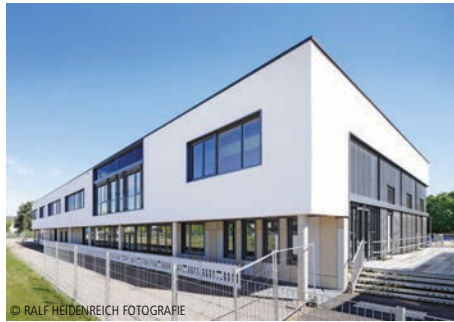
© RALF HEIDENREICH FOTOGRAFIE 6500-0064 Schulmensa, Großküche, Fachräume Gaststätten, Kantinen und Mensen Eßmann | Gärtner | Nieper Architekten GbR Darmstadt
