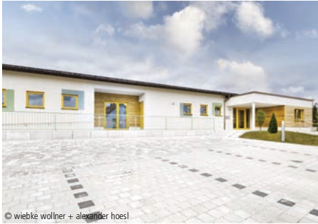
© wiebke wöllner + alexander hoesl 4400-0426 Kinderkrippe (24 Kinder) Kindergärten, Holzbauweise, nicht unterkellert Bindhammer Architekten Stadtplaner und Beratender Ingenieur Part mbB, Bayerbach
