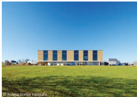
© Andreas Koehler Fotografie 7100-0075 Produktionshalle (10 AP) Lagergebäude, ohne Mischnutzung MxParchitektur Dachau
