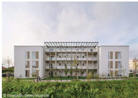
© Constantin Meyer Fotografie 6100-1779 Wohnanlage (5 Gebäude, 71 WE), TG Mehrfamilienhäuser, mit 20 oder mehr WE, mittl. Standard Reichel Architekten PartG mbB Kassel
