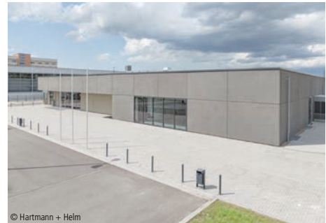
© Hartmann + Helm 5100-0143 Sporthalle (Dreifeldhalle) Sporthallen (Dreifeldhallen) Hartmann + Helm Planungsgesellschaft mbH Weimar
