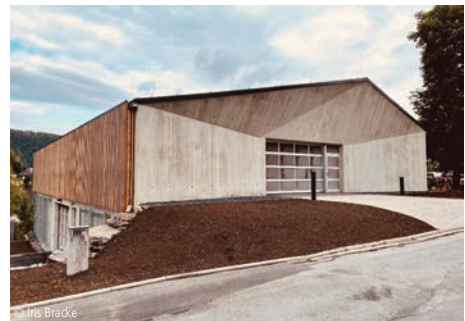
© Iris Bräcke 7800-0045 Parkscheune (21 STP) Mehrfachgaragen Müller Architekten GmbH Kronach
