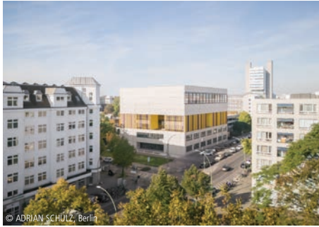
© ADRIAN SCHULZ, Berlin 4100-0253 Grundschule (448 Schüler) Allgemeinbildende Schulen Numrich Albrecht Klumpp Gesellschaft von Architekten mbH, Berlin
