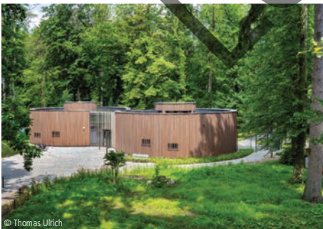
© Thomas Ulrich 9100-0225 Empfangsgebäude Bibliotheken, Museen und Ausstellungen MPP GmbH Architekten + Ingenieure Rostock
