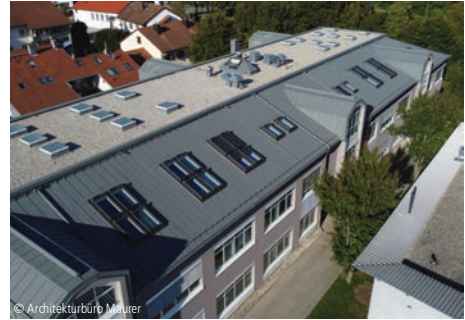
1300-0301 Bürogebäude, Dachsanierung Modernisierungen; Büro- und Verwaltungsgebäude Architekturbüro Maurer München
