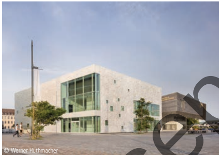
9100-0222 Ausstellungsgebäude Erweiterungen; Gebäude anderer Art Andreas Heller Architects & Designers Hamburg
