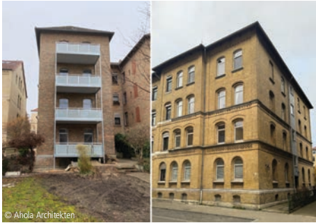
6100-1753 Mehrfamilienhaus (8 WE) Instandsetzungen; Wohngebäude Ahola Architekten Braunschweig
