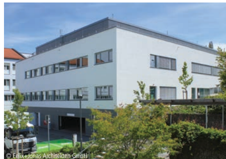
3200-0034 Krankenhaus Erweiterungen; Gebäude anderer Art Felix+Jonas Architekten GmbH München
