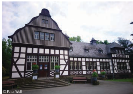
9100-0204 Stadtbücherei (120 Plätze) Modernisierungen; Gebäude anderer Art a5 Planung GmbH Bad Nauheim
