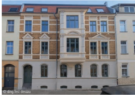
6100-1760 Mehrfamilienhaus (4 WE) Instandsetzungen; Wohngebäude ding.fest dessau architektur & energieberatung Dessau-Roßlau
