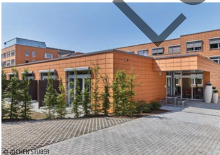
3200-0032 Palliativstation (12 Betten) Erweiterungen; Gebäude anderer Art Planungsring Mumm + Partner GbR Treia
