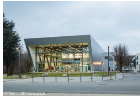
© Thomas Ott, www.o2t.de 2200-0070 Produktions-/Forschungshalle (14 AP) Instituts- und Laborgebäude pwpMAS Architekten PartG mbB Darmstadt
