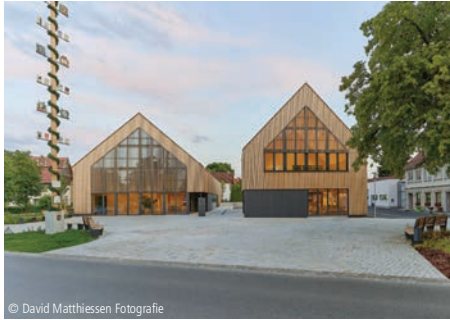
© David Matthiessen Fotografie 9100-0232 Gemeindesaal, Gaststätte Gemeindezentren, Holzbauweise f64 Architekten und Stadtplaner GmbH Kempten
