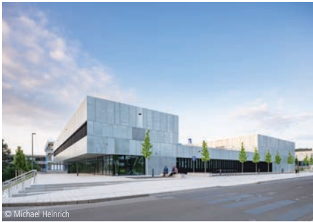
© Michael Heinrich 2200-0074 Forschungsgebäude (85 AP) Instituts- und Laborgebäude ARGE AV1 Architekten ASPLAN Architekten Kaiserslautern
