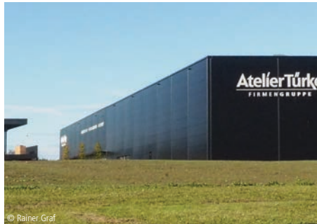
7700-0087 Lagerhalle Lagergebäude, ohne Mischnutzung RAINER GRAF architekten GmbH Ofterdingen
