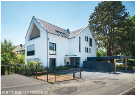
© Jan Wengenroth Photodesign 6100-1775 Mehrfamilienhaus (3 WE) Mehrfamilienhäuser, mit 6 bis 19 WE, mittlerer Standard lutz architekten GmbH Bad Honnef
