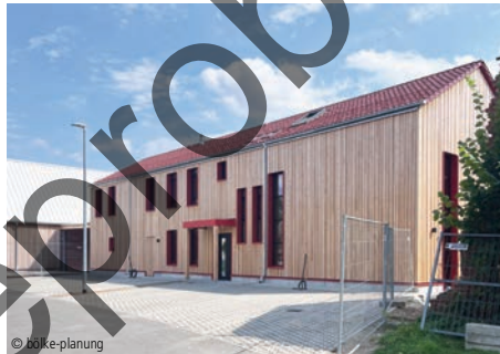
© böke-planung 1300-0341 Bürogebäude (10 AP) Büro- und Verwaltungsgebäude, Holzbauweise Siegmond Böke und Partner mbB Treuenbrietzen
