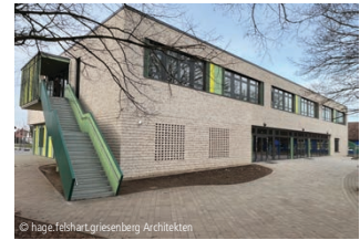
© Inge Feßhar/Liggesberg Architekten 4100-0270
