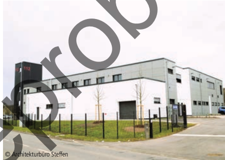
7600-0110 Feuerwehrhaus (5 Fahrzeuge) Feuerwehnhäuser
