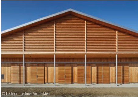
6400-0141 Jugendtreff, Veranstaltungssaal Gemeindezentren, Holzbauweise
