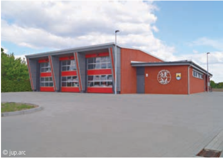
7600-0085 Feuerwehrhaus (3 Fahrzeuge) Feuerwehnhäuser
