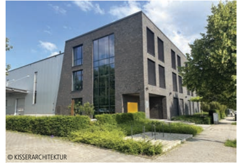
© KISSERARCHITEKTUR 7700-0098 Konfektionierungshalle, Büros Betriebs- u. Werkstätten, mehrgeschossig, hoh. Hallenteil KISSERARCHITEKTUR Isernhagen
