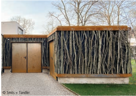
© Smits + Tandler 7700-0096 Wirtschaftsgebäude Friedhofsgebäude
