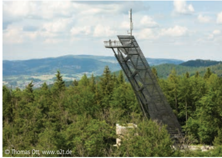
9100-0227 Aussichtsturm Ohne Gebäudeartenzuordnung pwpMAS Architekten PartG mbB Darmstadt
