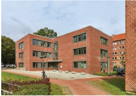
1300-0262 Verwaltungsgebäude (48 AP) Büro- und Verwaltungsgebäude, mittlerer Standard Planungsring Mumm + Partner GbR Treia
