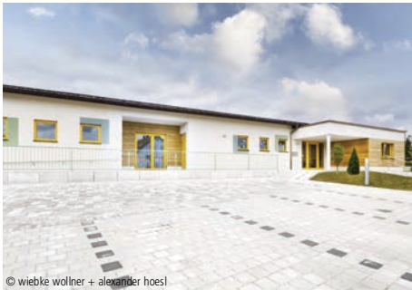
© wiebke wöllner + alexander hoesl 4400-0426 Kinderkrippe (24 Kinder) Kindergärten, Holzbauweise, nicht unterkellert Bindhammer Architekten Stadtplaner und Beratender Ingenieur Part mbB, Bayerbach
