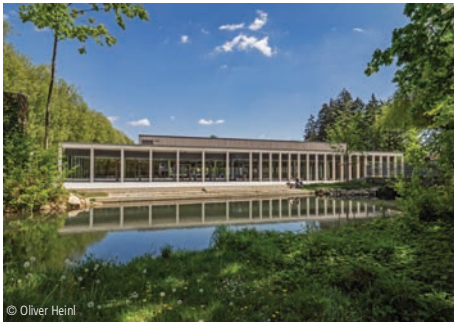
5100-0148 Mehrzweckhalle (1.650 Sitzplätze) Sport- und Mehrzweckhallen Fuchs und Rudolph Architekten und Stadtplaner München
