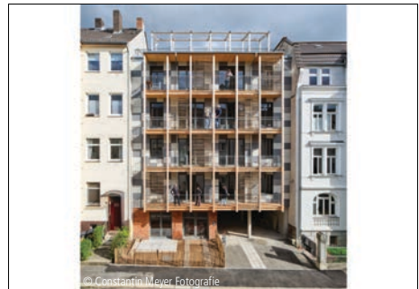
© Constantin Meyer Fotografie 6100-1772 Mehrfamilienhaus (9 WE, 3 STP) Mehrfamilienhäuser, mit 6 bis 19 WE, einfacher Standard ☞ foundation 5+ architekten BDA Kassel
