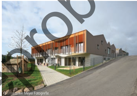
© Konstantin Meyer Fotografie 4400-0430 Kindertagesstätte (124 Kinder) Kindergärten, Holzbauweise, nicht unterkellert foundation 5+ architekten BDA Kassel
