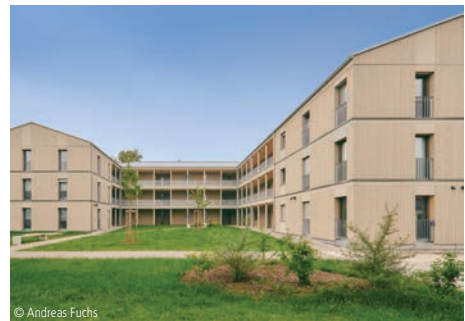
© Andreas Fuchs 6100-1806 Mehrfamilienhaus (18 WE) Mehrfamilienhäuser, Holzbauweise Weidner Architektur Weiden
