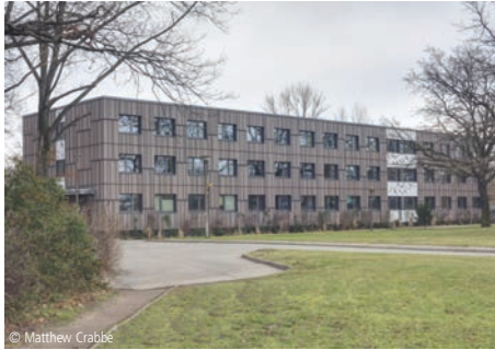
1300-0270 Verwaltungsgebäude (75 AP) Modernisierungen; Büro- und Verwaltungsgebäude ZRS Architekten GvA mbH Berlin
