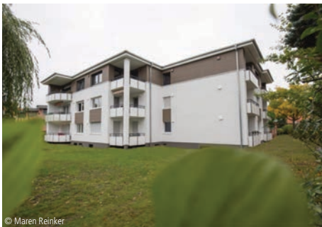
6100-1536 Mehrfamilienhaus (12 WE) Modernisierungen; Wohngeb. n. 1945: mit Tragkonstruktion ☐ Ingenieurbüro Gerdorf Bad Essen
