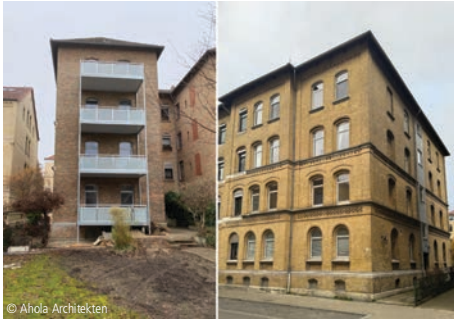
6100-1753 Mehrfamilienhaus (8 WE) Instandsetzungen; Wohngebäude Ahola Architekten Braunschweig
