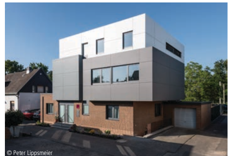
6100-1746 Einfamilienhaus, Aufstockung Erweiterungen; Wohngebäude: Aufstockung Gütig Architektur Bornholm-Hersel
