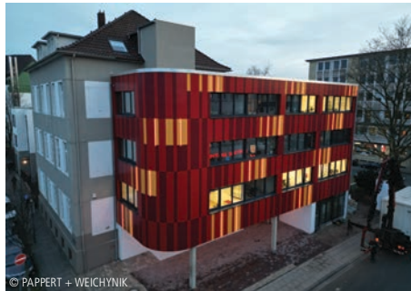
1300-0336 Bürogebäude (34 AP) Erweiterungen; Büro- und Verwaltungsgebäude PAPPERT + WEICHYNIK Architekten PartG mbB Bielefeld
