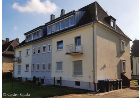
6100-1493 Dachgeschoss (2 WE) Umbauten; Ein- und Zweifamilienhäuser ☐ KAPALAARCHITEKTUR Carsten Kapala Herne
