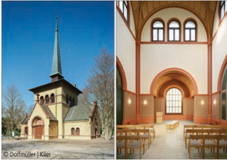
9700-0032 Friedhofskapelle Instandsetzungen; Sakralbauten Dohse und Partner Architekten mbB Hamburg
