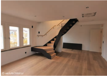
6100-1609 Dachgeschosswohnung, Turmzimmer Umbauten; Wohnungen werkArchitektur Yvonne Werk Berlin
