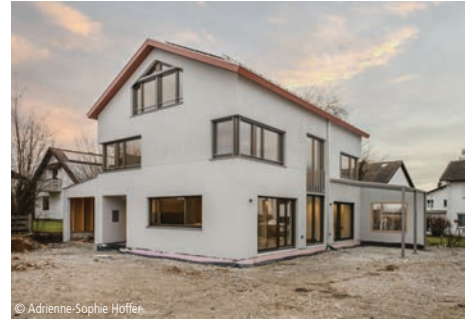
© Adrienne-Sophie Hoffen 6100-1783 Einfamilienhaus, Garage Ein- und Zweifamilienhäuser, unterkellert, hoher Standard Knopp Wassmer Architekten PartG mbB München
