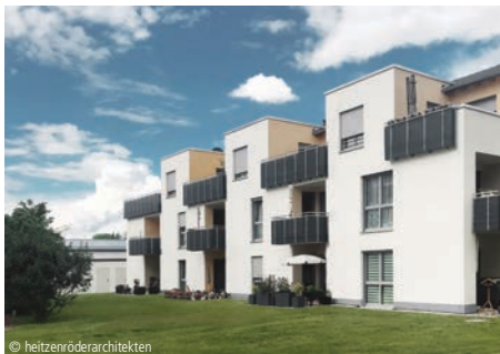
© heitzenröderarchitekten 6100-1755 Mehrfamilienhaus (12 WE) Mehrfamilienhäuser, mit 6 bis 19 WE, mittlerer Standard heitzenröderarchitekten GmbH Hanau
