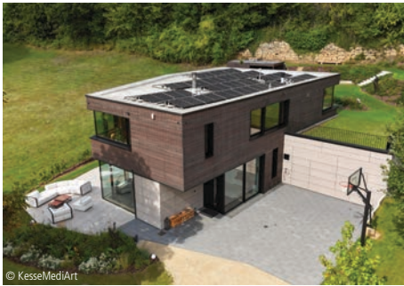
6100-1815 Einfamilienhaus, Doppelgarage Ein- und Zweifamilienhäuser, Holzbauweise, unterkellert cl.ar Carsten Larusch Architektur Bitburg
