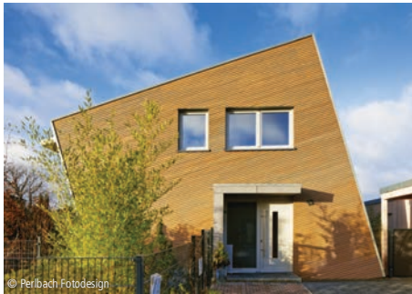
6100-1768 Einfamilienhaus Ein- u. Zweifamilienhäuser, Holzbauweise, nicht unterkellert AX5 architekten, Kiel und Wolf Weiss, Bönebüttel
