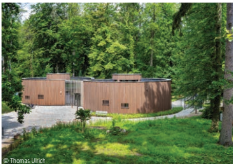
© Thomas Ulrich 9100-0225 Empfangsgebäude Bibliotheken, Museen und Ausstellungen MPP GmbH Architekten + Ingenieure Rostock
