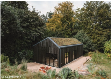
© Kai Pöhlkamp 6100-1764 Einfamilienhaus Ein- und Zweifamilienhäuser, unterkellert, hoher Standard feldhaus architekten partnerschaft mbB Ibbenbüren
