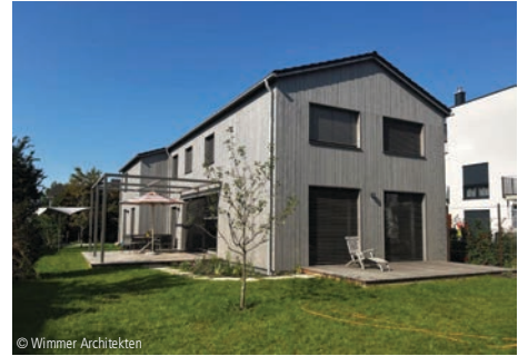
© Wimmer Architekten 6100-1802 Einfamilienhaus, Doppelgarage Ein- und Zweifamilienhäuser, unterkellert, hoher Standard Wimmer Architekten GbR Rosenheim
