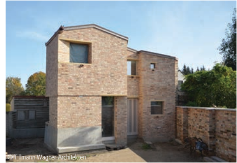
© Tillmann Wagner Architekten 6100-1750 Einfamilienhaus Ein- u. Zweifamilienhäuser, nicht unterkell., hoher Standard Tillmann Wagner Architekten BDA Berlin
