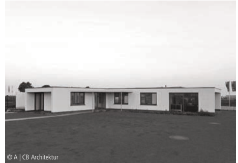
1300-0332 Bürogebäude (10 AP), Doppelgarage Büro- und Verwaltungsgebäude, mittlerer Standard A | CB Architektur Ratzeburg
