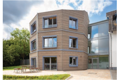
© Axel Hartmann Fotografie 1300-0349 Büro- und Betriebsgebäude (12 AP) Büro- und Verwaltungsgebäude, hoher Standard Shakti Haus Bad König
