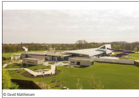
© David Matthiessen 5200-0019 Sport- und Freizeitbad Schwimmhallen 4a Architekten GmbH Stuttgart
