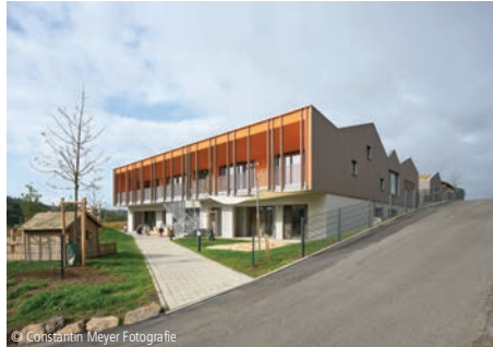
© Constantin Meyer Fotografie 4400-0430 Kindertagesstätte (124 Kinder) Kindergärten, Holzbauweise, nicht unterkellert foundation 5+ architekten BDA Kassel
