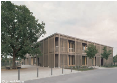
© Simon Menges 4400-0423 Kindertagesstätte (106 Kinder) Kindergärten, Holzbauweise, nicht unterkellert Knoche Architektur PartGmbH Leipzig
