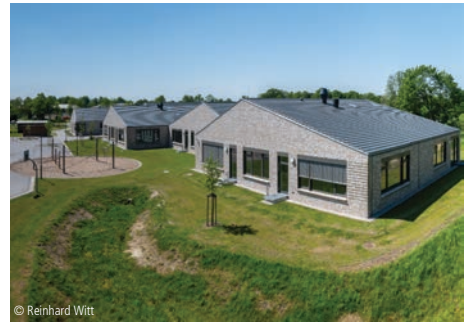
© Reinhard Witt 4100-0261 Grundschule (150 Schüler) Schulen, Holzbauweise JF Architekten + Techniker Husum
