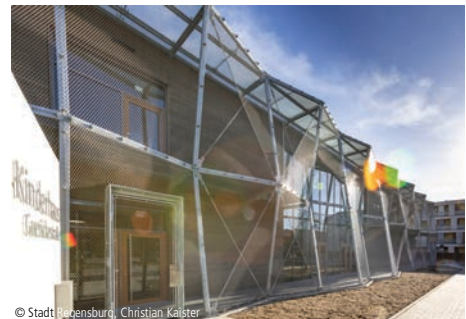
© Stadt Regensburg, Christian Koeler 4400-0424 Kindertagesstätte (152 Kinder) Kindergärten, Holzbauweise, nicht unterkellert Stadt Regensburg, Amt für Hochbau Regensburg
