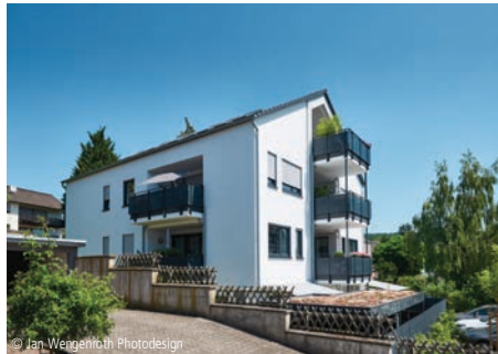
6100-1776 Mehrfamilienhaus (5 WE) Mehrfamilienhäuser, mit 6 bis 19 WE, mittlerer Standard lutz architekten GmbH Bad Honnef
