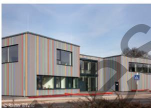
Grundschule mit vier Klassen für 160 Schüler. Mischkonstruktion: Holzrahmenbau, Mauerwerk, Stahlbeton.
