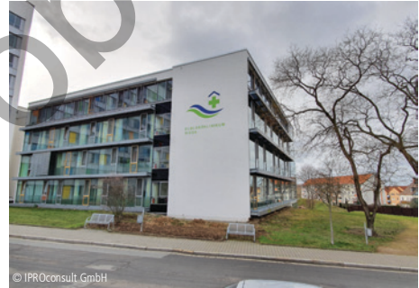
3200-0033 Krankenhaus, Aufstockung Bettenhaus (48 B) Erweiterungen; Gebäude anderer Art
