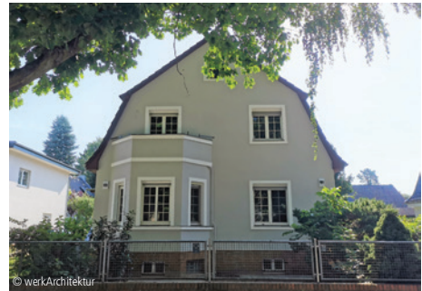
© werkArchitektur 6100-1599 Zweifamilienhaus Instandsetzungen; Wohngebäude werkArchitektur Berlin
