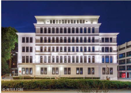
1300-0250 Verwaltungsgebäude, Fassadensanierung Modernisierungen; Büro- und Verwaltungsgebäude
