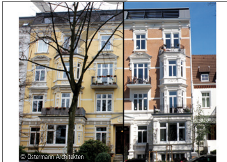
© Ostermann Architekten 6100-1502 Mehrfamilienhaus, Schwammsanierung Instandsetzungen; Schwammsanierung Ostermann Architekten Hamburg
