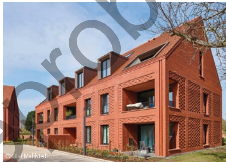
6100-1675 Mehrfamilienhäuser (2 Gebäude, 15 WE) Mehrfamilienhäuser, mit 6 bis 19 WE, hoher Standard saboArchitekten BDA Hannover
