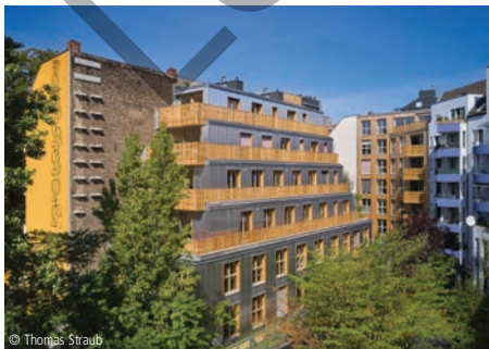
© Thomas Straub 6100-1669 Mehrfamilienhäuser (2 Gebäude, 18 WE, 2 GE) Mehrfamilienhäuser, mit 6 bis 19 WE, hoher Standard IFUB GmbH Berlin
