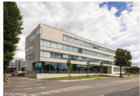
© Jörg Hempel 1300-0306 Bürogebäude (240 AP) Büro- und Verwaltungsgebäude, mittlerer Standard SSP AG Bochum
