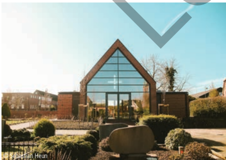
© Sebastian Heun 9700-0034 Friedhofskapelle (40 Sitzplätze) Friedhofsgebäude Bocklage + Buddelmeyer Architekten GmbH Vechta
