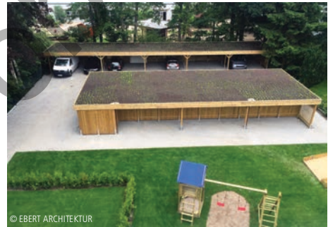
© EBERT ARCHITEKTUR 6100-1646 Carports (16 STP), Fahrradstellplätze Carports EBERT ARCHITEKTUR Hamburg
