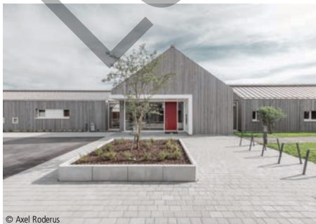
© Axel Roderus 4400-0366 Kinderhaus (4 Gruppen, 74 Kinder) Kindergärten, Holzbauweise, nicht unterkellert
