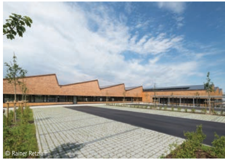
7100-0070 Produktionshalle (268 AP) Industrielle Produktionsgebäude, überwiegend Skelettbau f64 Architekten und Stadtplaner PartGmbH Kempten
