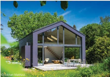
© Eckhart Matthäus 6100-1610 Einfamilienhaus
