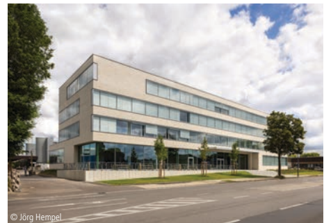
© Jörg Hempel 1300-0306 Bürogebäude (240 AP) Büro- und Verwaltungsgebäude, mittlerer Standard SSP AG Bochum
