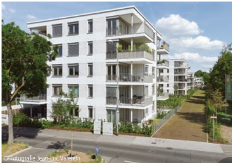
6100-1622 Mehrfamilienhäuser (5 Gebäude, 66 WE), TG Mehrfamilienhäuser, mit 20 oder mehr WE, hoh. Standard ☞ grabowski.spork GmbH Wiesbaden
