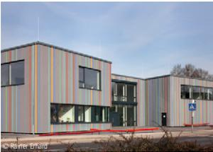
Grundschule mit vier Klassen für 160 Schüler als Effizienzhaus ~3%. Mischkonstruktion: Holzrahmenbau, Mauerwerk, Stahlbeton.
