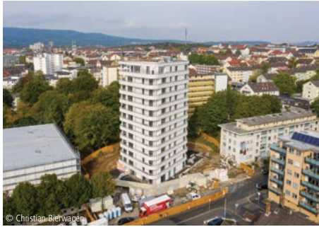
© Christian Bleh Wagner 6100-1614 Wohnturm (21 WE), TG (21 STP) Mehrfamilienhäuser, mit 20 oder mehr WE, hoh. Standard roller architekten gmbh Kassel
