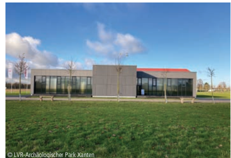
9100-0206 Ausstellungspavillon Bibliotheken, Museen und Ausstellungen LVR-Archäologischer Park Xanten Bauabteilung Xanten
