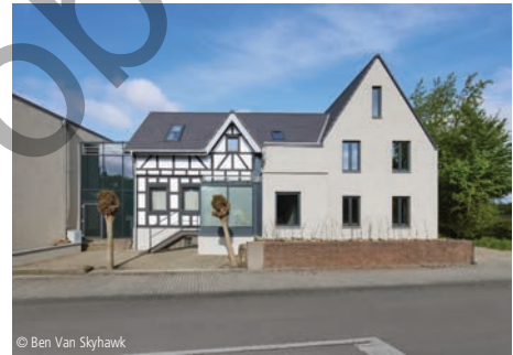
© Ben Van Skyhawk 6100-1631 Mehrfamilienhaus (2 WE) Ein- u. Zweifamilienhäuser, nicht unterkell., mittl. Standard Wendling Architektur Köln-Deutz
