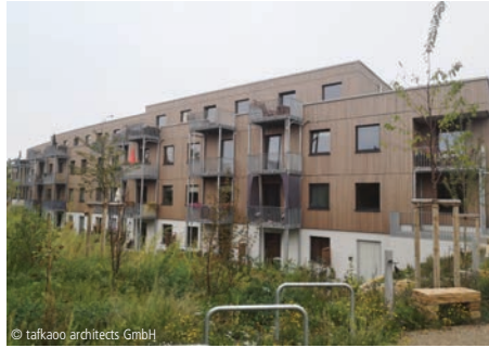
6100-1650 Mehrfamilienhaus (42 WE) Mehrfamilienhäuser, mit 20 oder mehr WE, hoh. Standard tafkaoo architects GmbH Berlin
