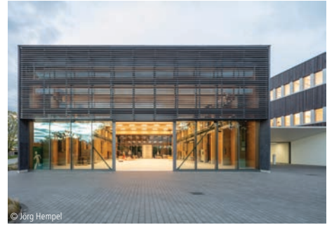
© Jörg Hempel 2200-0063 Labor-/Bürogebäude, Prüffeldhalle (39 AP) Instituts- und Laborgebäude ZELUBA DGI Bauwerk, Berlin und schneider+schumacher, Frankfurt/Main
