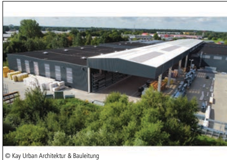
7700-0094 Lagerhalle, überdachte Ladezone Lagergebäude, ohne Mischnutzung Kay Urban Architektur & Bauleitung Lübeck
