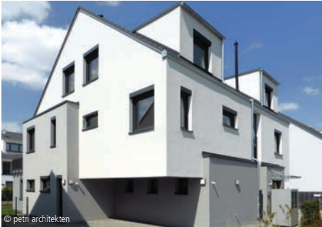
6100-1674 Mehrfamilienhaus (3 WE) Mehrfamilienhäuser, mit bis zu 6 WE, mittlerer Standard petri architekten Dreieich
