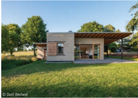
© Dorit Werheid 6100-1628 Einfamilienhaus Ein- u. Zweifamilienhäuser, nicht unterkell., hoher Standard Kai Matzak Köln
