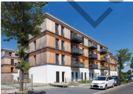
© Janina Heppner 6100-1626 Mehrfamilienhäuser (2 Gebäude, 42 WE) Mehrfamilienhäuser, mit 20 oder mehr WE, mittl. Standard ☞ Peter Ruge Architekten GmbH Berlin
