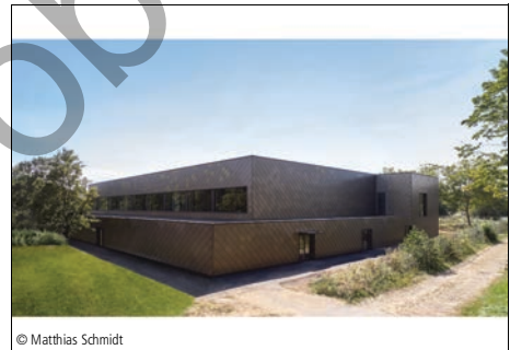
© Matthias Schmidt 5100-0142 Mehrzweckhalle (540 Sitzplätze) Sport- und Mehrzweckhallen Architekten BDA Naujack.Rind.Hof GmbH, Koblenz u. PLANFAKTUR Architekten BDA PartGmbH, Montabaur
