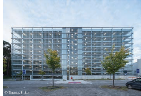
7800-0033 Parkhaus (804 STP) Hochgaragen Lengfeld & Wilisch Architekten PartG mbB Darmstadt
