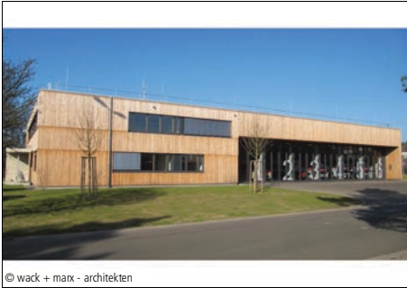
7600-0098 Werkfeuerwehr (6 Fahrzeuge) Feuerwehnhäuser wack + marx - architekten St. Ingbert
