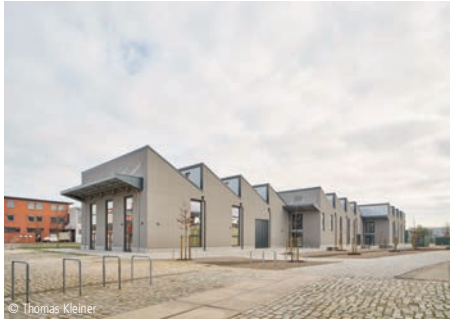
© Thomas Kleiner 2200-0062 Atelier-/Werkhallen, Veranstaltungshalle Instituts- und Laborgebäude GSP Gerlach Schneider Partner Architekten mbB Bremen
