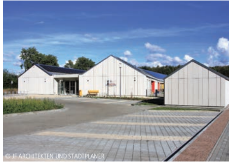
© JF ARCHITEKTEN UND STADTPLANER 4400-0370 Kindertagesstätte (6 Gruppen, 100 Kinder) Kindergärten, nicht unterkellert, mittlerer Standard JF ARCHITEKTEN UND STADTPLANER Fuchs und Dycker PartG mbB BDA, Husum
