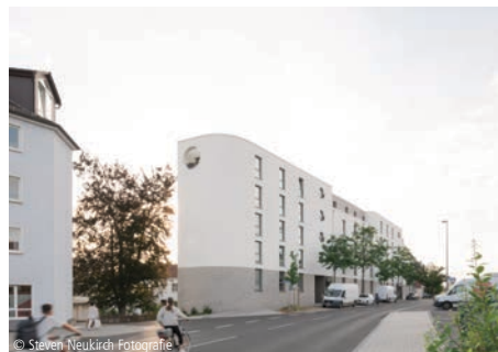
© Steven Neukirch Fotografie 6100-1613 Mehrfamilienhaus (44 WE) Mehrfamilienhäuser, mit 20 oder mehr WE, mittl. Standard Reith Wehner Storch Architekten Fulda
