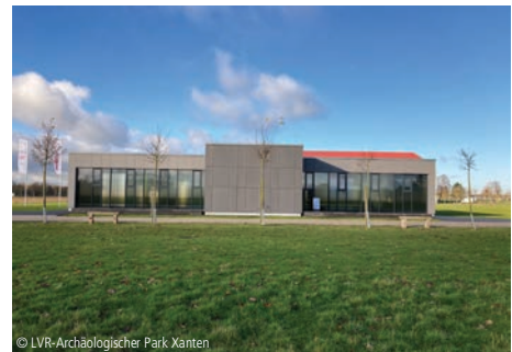
9100-0206 Ausstellungspavillon Bibliotheken, Museen und Ausstellungen LVR-Archäologischer Park Xanten Bauabteilung Xanten
