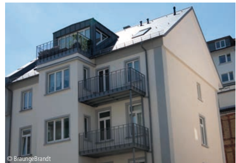
6100-1579 Mehrfamilienhaus (4 WE) Modernisierungen; Wohngebäude nach 1945: Oberflächen BraungeBrandt Planungsstudio Wiesbaden
