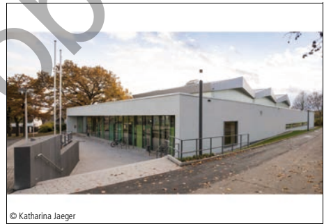
5100-0122 Sporthalle (Zweifeldhalle) Modernisierungen; Sporthallen KM architekten bda Kassel
