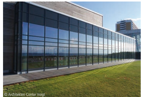
5200-0012 Sportbadhalle Erweiterungen; Gebäude anderer Art Architekten Contor Voigt Itzehoe
