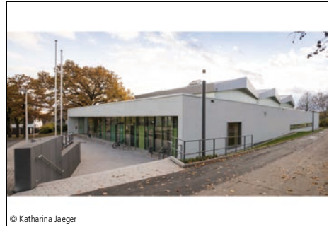
5100-0122 Sporthalle (Zweifeldhalle) Modernisierungen; Sporthallen
