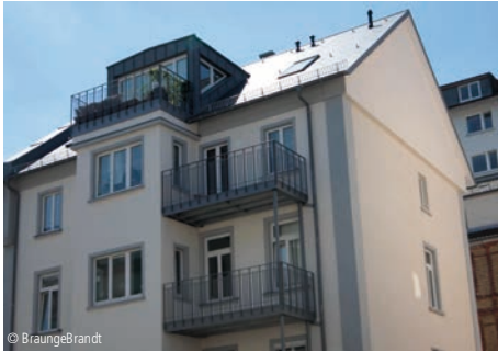
6100-1267 Mehrfamilienhaus (4 WE), Dachausbau Umbauten; Mehrfamilienhäuser
